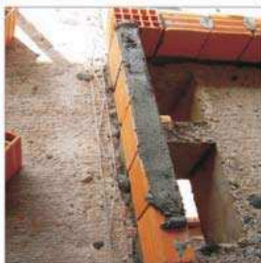
1ª Etapa: Aplicação da argamassa de assentamento na primeira fiada
