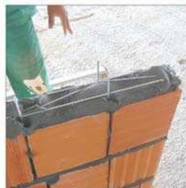
3ª Etapa: Assentamento das próximas fiadas de blocos
